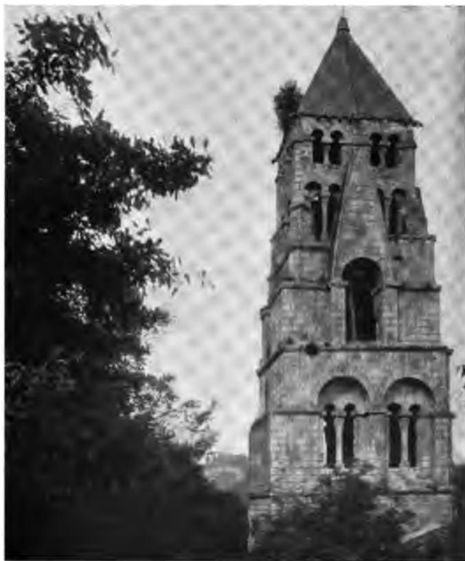
Fig. 47. — Superposition des supports montés en retrait sur encorbellements au clocher de Brantôme (Dordogne). XII e siècle.
